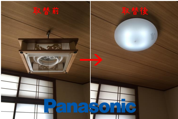
松茂町 K様 照明取替工事
