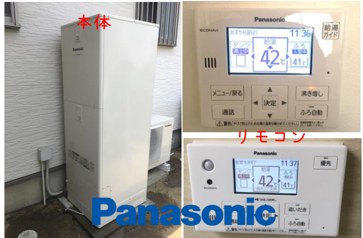
松茂町 S様 エコキュート取替工事
