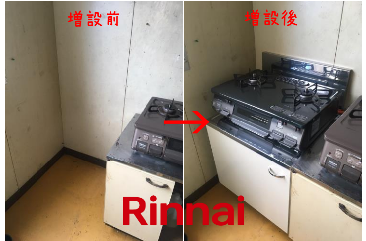
松茂町 T様 テーブルガスコンロ増設工事
