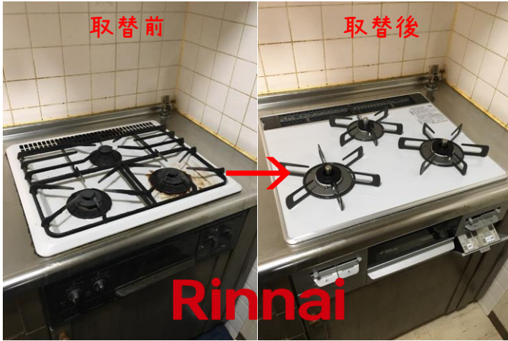
徳島市西新浜町 I様 ガスコンロ取替工事
