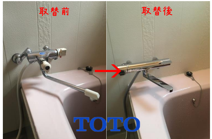
藍住町 H様 浴室水栓取替工事
