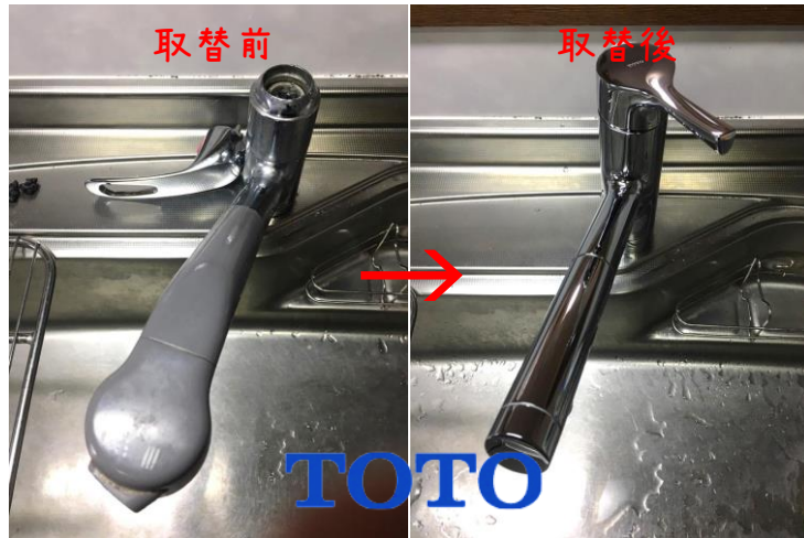
北島町 S様 台所水栓取替工事
