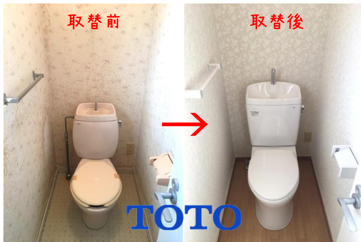
北島町 T様 トイレ取替工事・内装貼替工事
