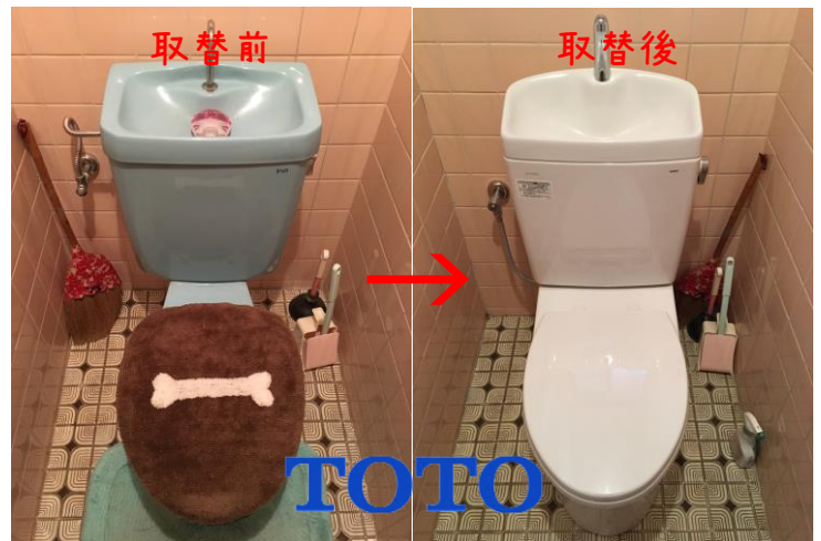
松茂町 I様 トイレ取替工事
