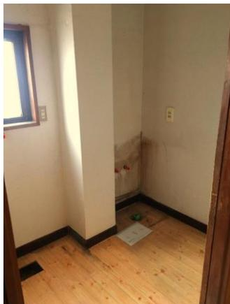
システムバスとドア枠周りの壁を解体します。洗面台と洗濯パンも撤去します。
