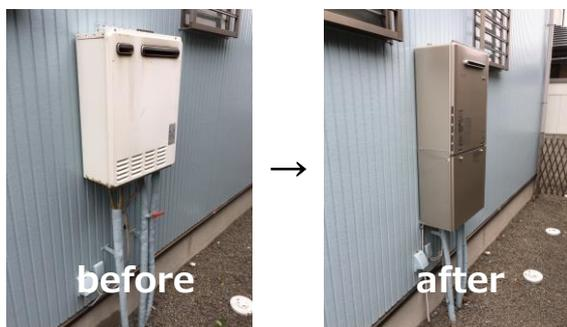
エコジョーズタイプの給湯器へ取り替えたので、毎月のガス使用量を約15%削減できます。
