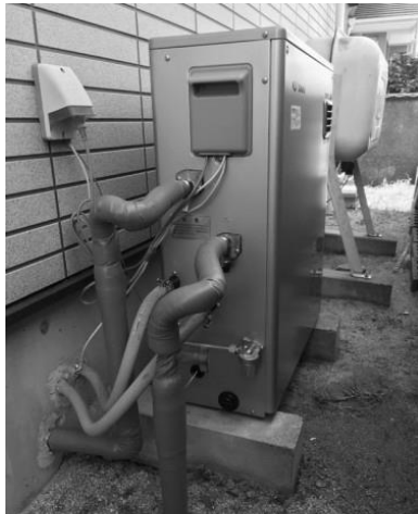
松茂町 N様 CHOFU 製 灯油ボイラー取替工事
