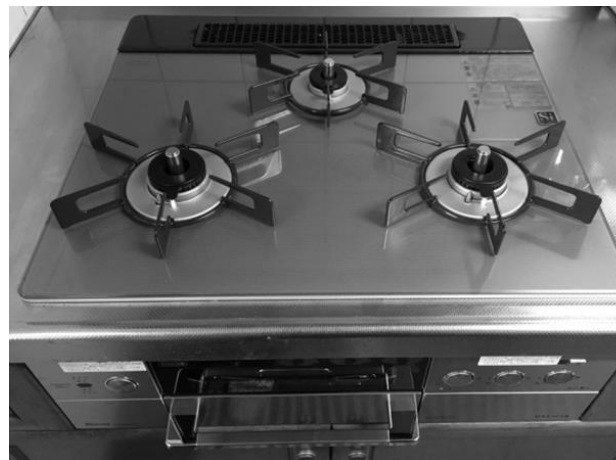
応神町 B様 リンナイ製 ビルトインガスコンロ取替工事
