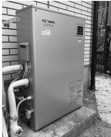
那賀川町 T様 CHOFU 製 省エネ型灯油ボイラー取替工事
