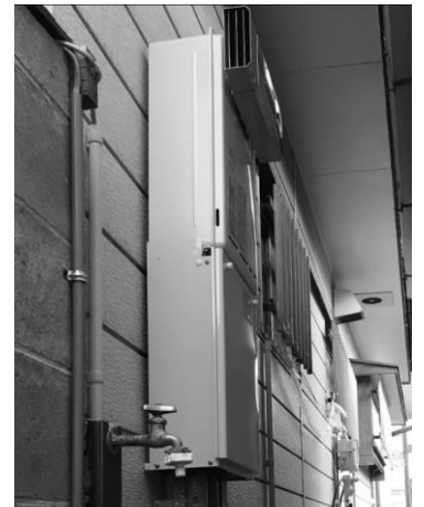
鳴門市 T様 リンナイ製 ガス給湯器取付工事
