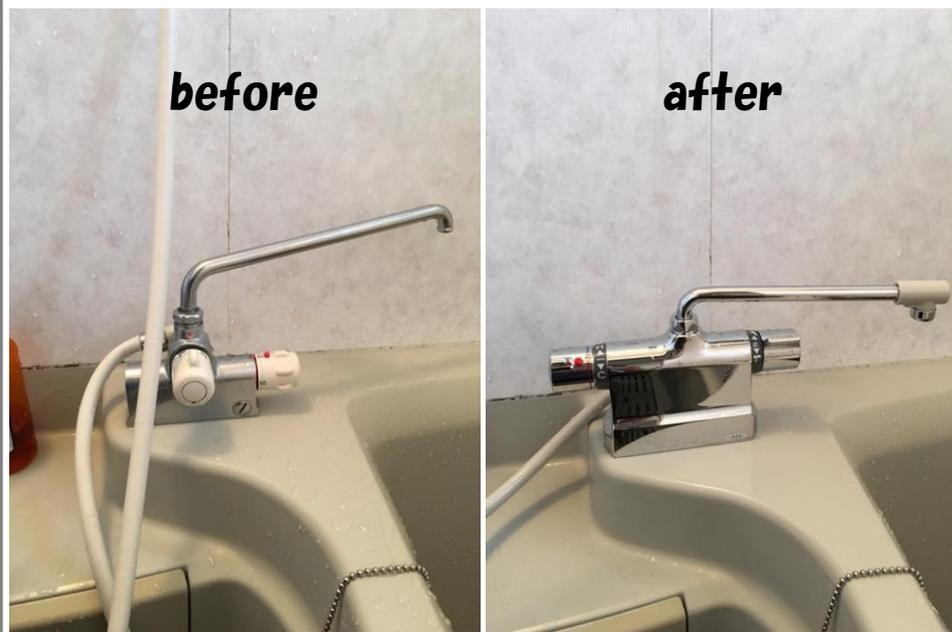
浴室でよく使われている、温度調整が簡単に出来る水栓(サーモスタート式混合水栓)の取り替え工事も行っております。お湯の温度が不安定になる等の症状があれば、故障のサインです。
