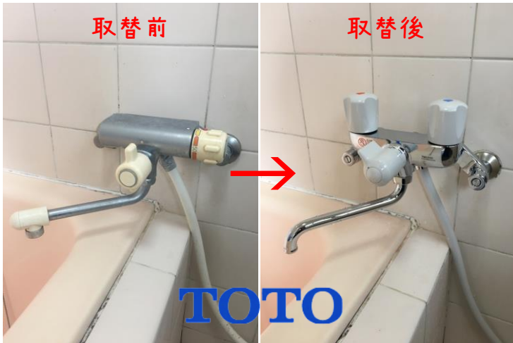
松茂町 H様 浴室水栓取替工事
