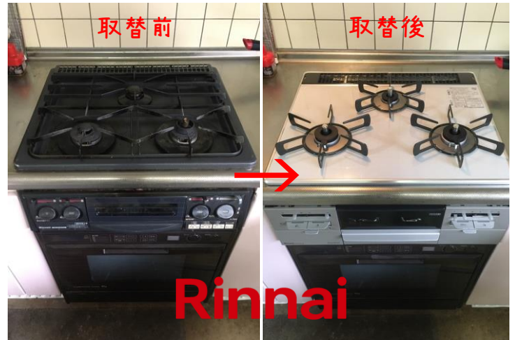
松茂町 Y様 ビルトインガスコンロ取替工事
