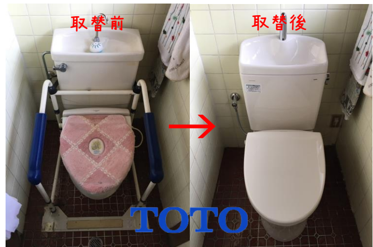
松茂町 Y様 組み合わせトイレ取替工事
