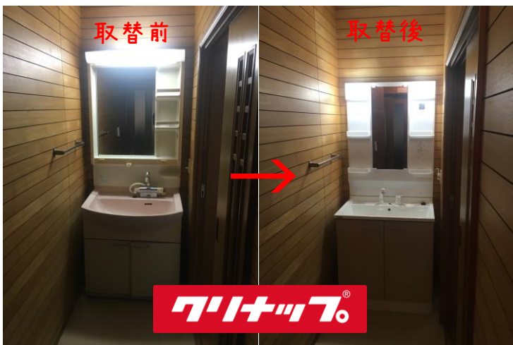
松茂町 T様 洗面化粧台取替工事
