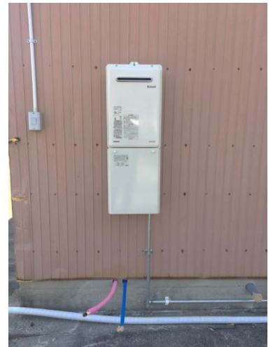
ガス給湯器の設置
