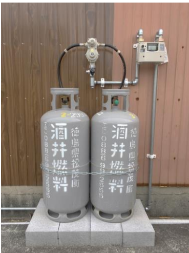
ガス供給設備の設置
